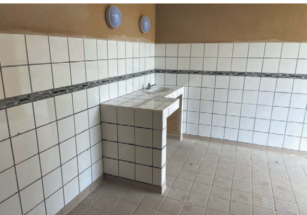
Ci-dessous : Réparation et embellissement des toilettes publiques parking de l'église. Souvent dégradés.
